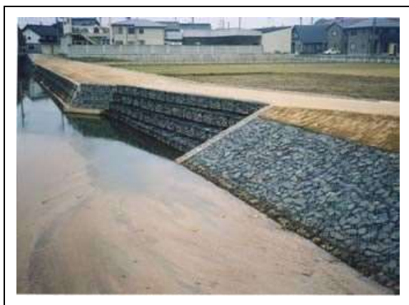
写真 7.4-13 木戸川（下流工区）
