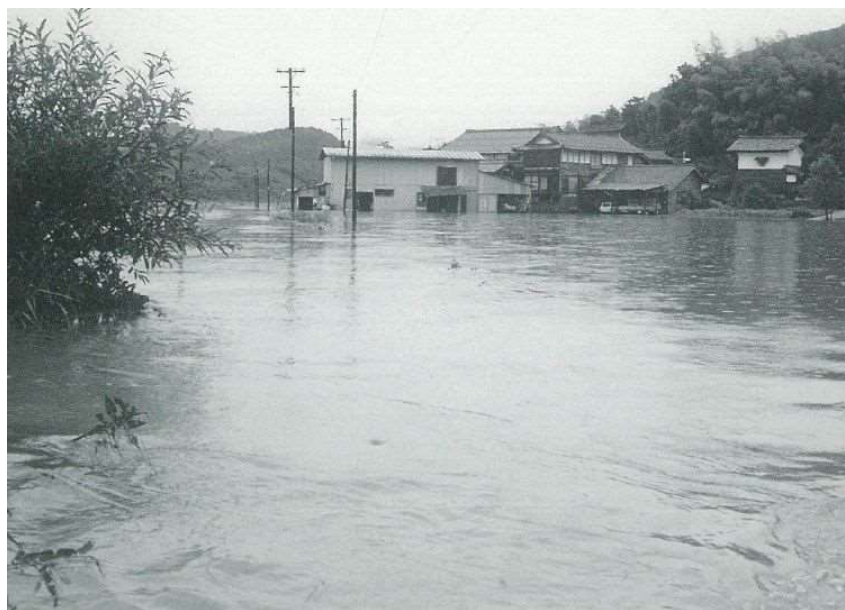
写真 7.1-5 津田平川の氾濫による浸水
