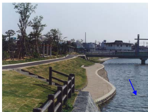
北公園と一体となった親水護岸（京橋川）
