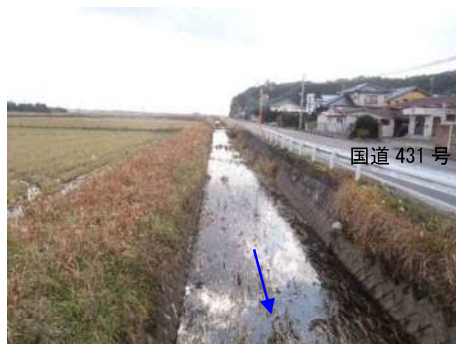
市道国富大津線（美談駅）付近上流
