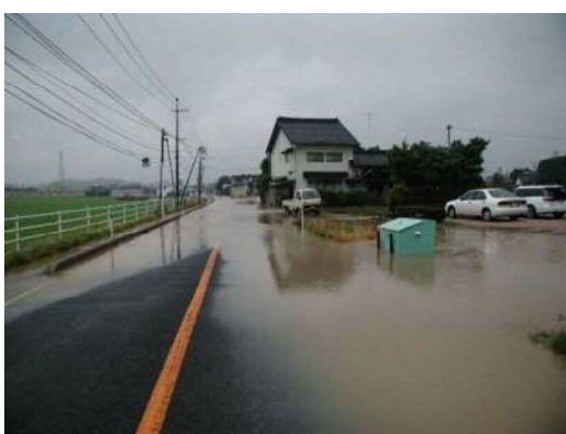
写真-3.1.5 平成 17 年 6 月洪水 (湯谷川・国道 431 号：出雲市国富町)
