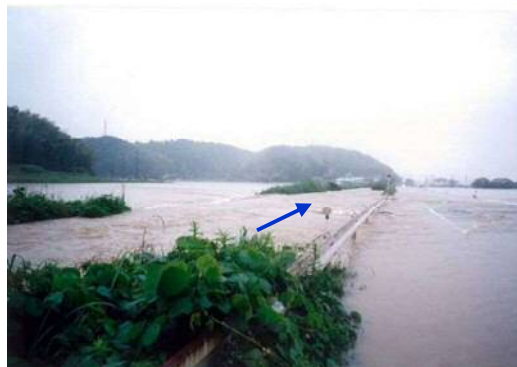
写真-3.1.4 平成 13 年 6 月洪水 (平田船川・県道鱈淵寺線：出雲市国富町)
