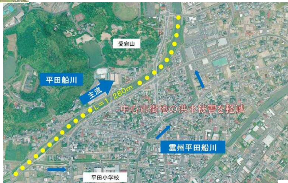
●河川改修後（平成24年撮影）
