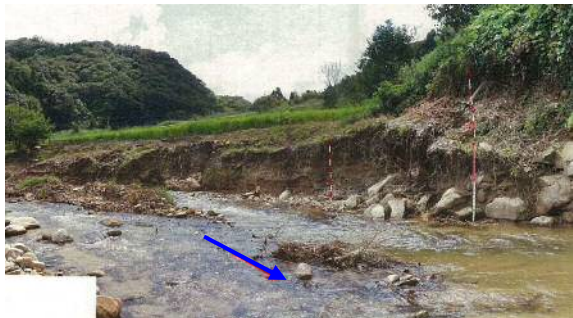
護岸の被害状況（復旧）
