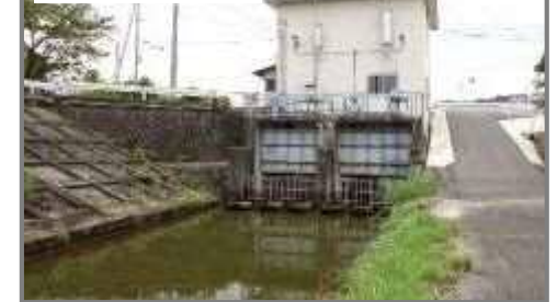
内原川排水機場
