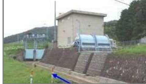
奥田川排水機場
