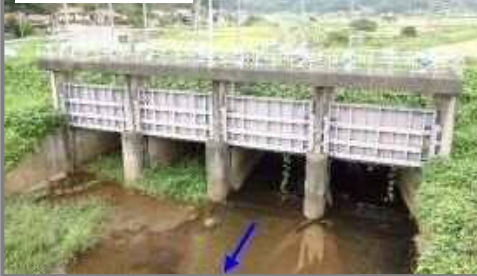
中村川大樋門
