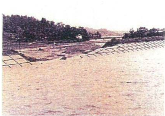
赤川堤防の決壊（大東町）
