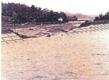
赤川堤防の決壊 (雲南市大東町)
