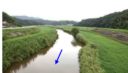
③-2 八口橋上流（赤川）
