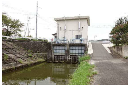
内原川排水機場
