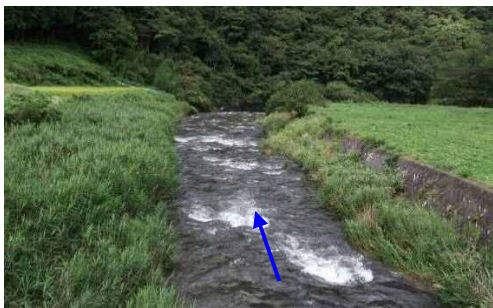
⑦-1 川上橋下流 (三刀屋川)
