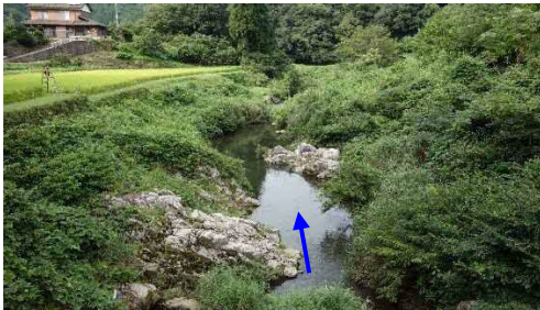
⑪-1 後ヶ谷橋下流 (阿井川)
