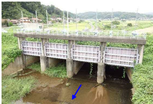
中村川大樋門
