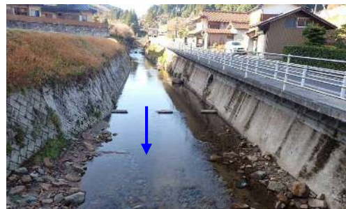
⑬-2 滝口橋上流 (飯石川)
