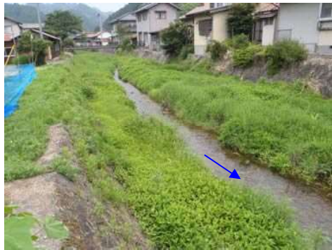
⑬玉川（下流部）
