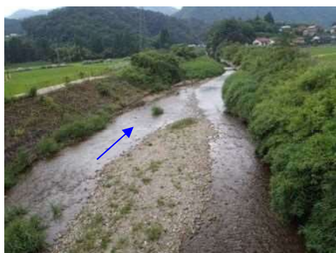
⑪日和川（日和川橋下流）
