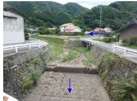
⑭枕の滝川・宮の谷川（下流部）
