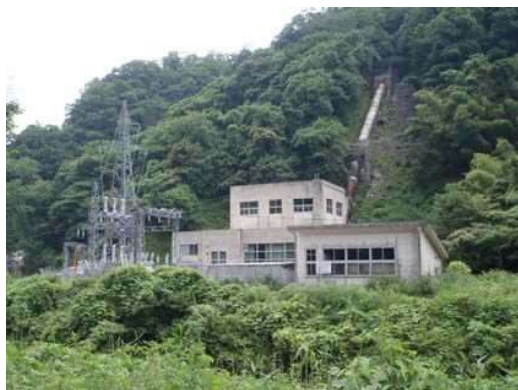
写真-3.2.1 八戸川第一発電所
