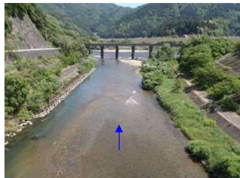
⑩八戸川（近原橋下流）
