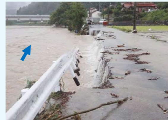
長尾地区の堤防がこわれた
