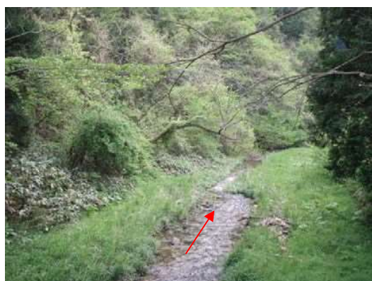
上流狭窄部（千坊橋下流）
