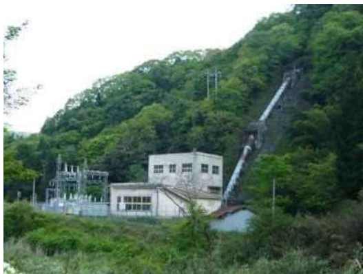
写真-3.2.1 八戸川第一発電所
