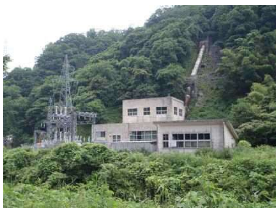
写真－3.2.1 八戸川第一発電所
