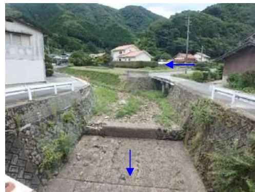
⑭枕の滝川・宮の谷川（下流部）
