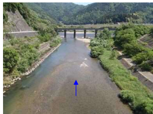
⑩八戸川（近原橋下流）
