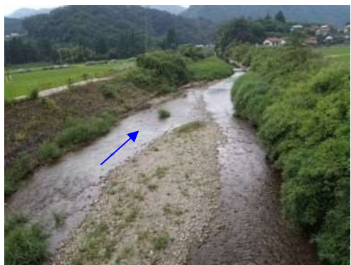
⑪日和川（日和川橋下流）
