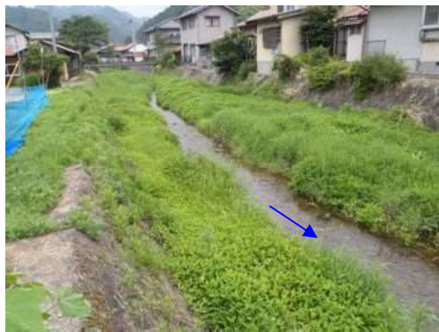
⑬玉川（下流部）
