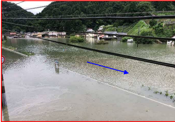
矢谷川：川本町谷地区 はまだばし 浜田橋（平成 30 年 7 月）
