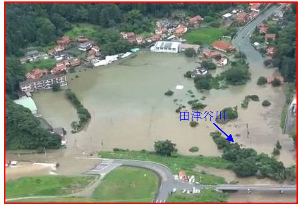
田津谷川：江津市川越地区（令和 2 年 7 月）
