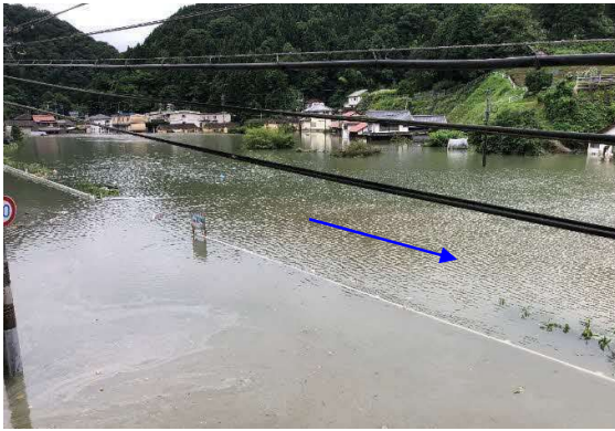
矢谷川：川本町谷地区 はまたばし 浜田橋（平成 30 年 7 月）
