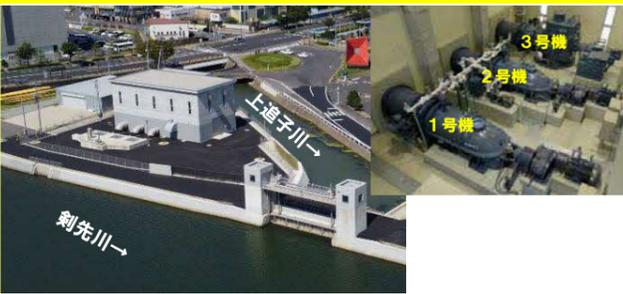
排水総能力 10.4m<sup>3</sup>/s(3台)のポンプ整備が令和2年10月に完了し、周辺の堤防整備も令和3年9月に完了しました。
