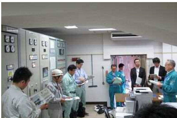
平成 30 年 現地確認 実施状況 →
