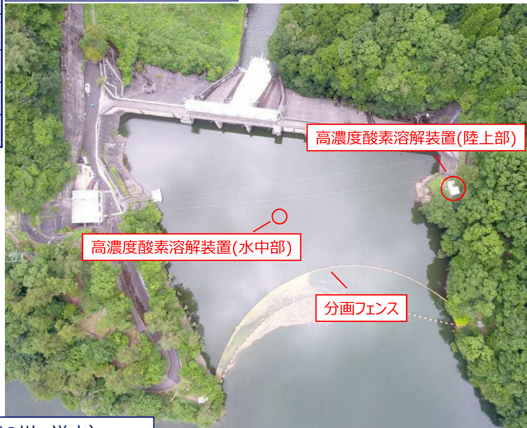
来島ダム水質保全設備
