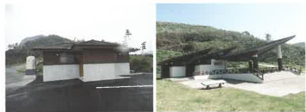
公衆トイレの改築・改修
