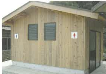
新たに設置した耳浦野営場トイレ
