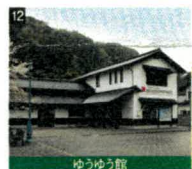
12 ゆうゆう館 1300年の歴史を有する温泉津温泉の温泉津港側の玄関口にあり、2階が資料館、1階が休憩所となっている。
