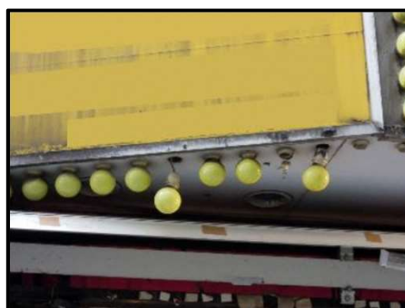
ソケットの破損
