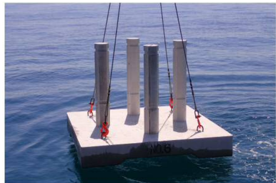
施工状況：柱状礁の設置
