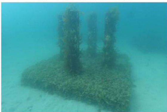
設置状況：施工後1年経過(海藻類が着生)
