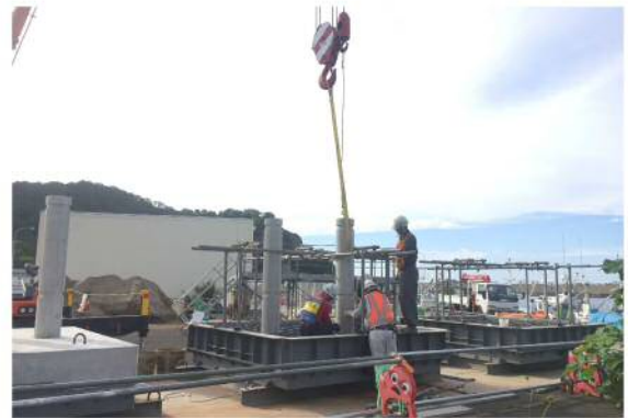
施工状況：柱状礁の製作
