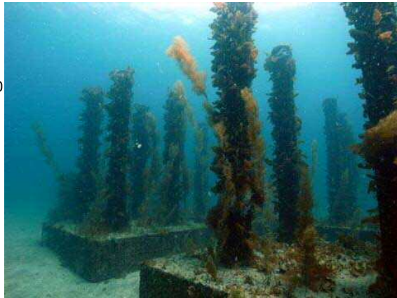
設置後約1年の柱状礁(ベーシック)
