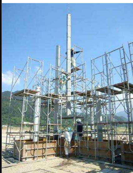
柱状部建込作業
