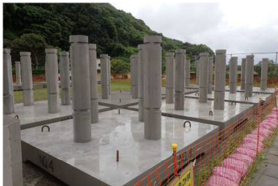
施工状況：柱状礁の製作
