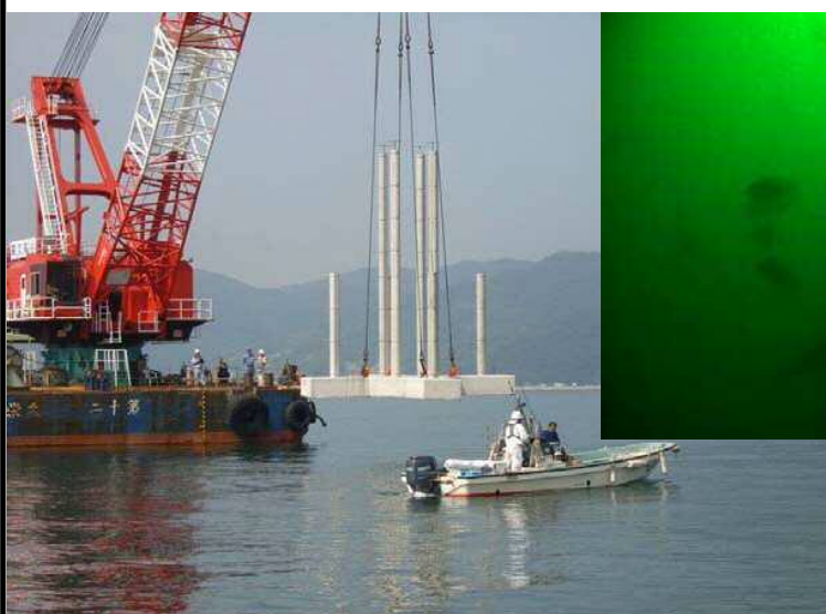
大型十字礁設置工事
