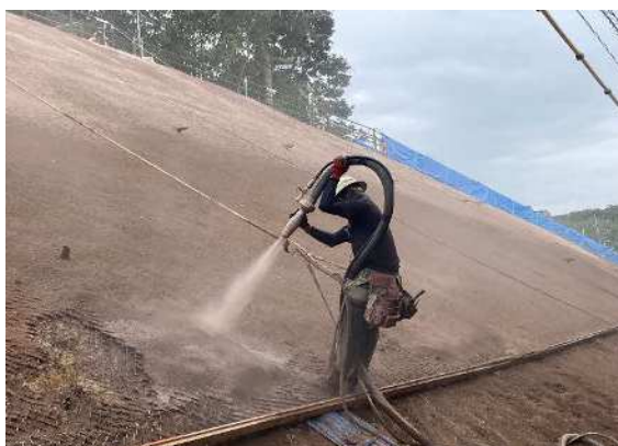
【乾式による吹付作業】
