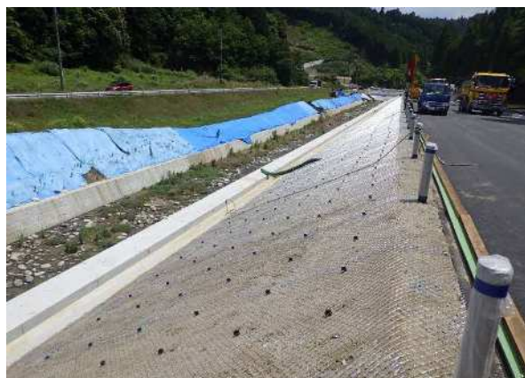
ラス張工 (盛土面)
