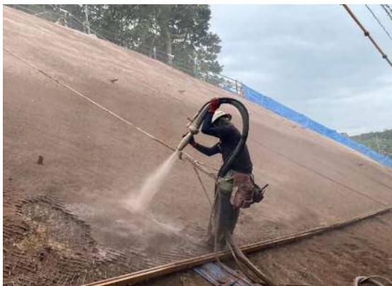
【乾式による吹付作業】
