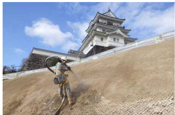
【乾式吹付作業】
