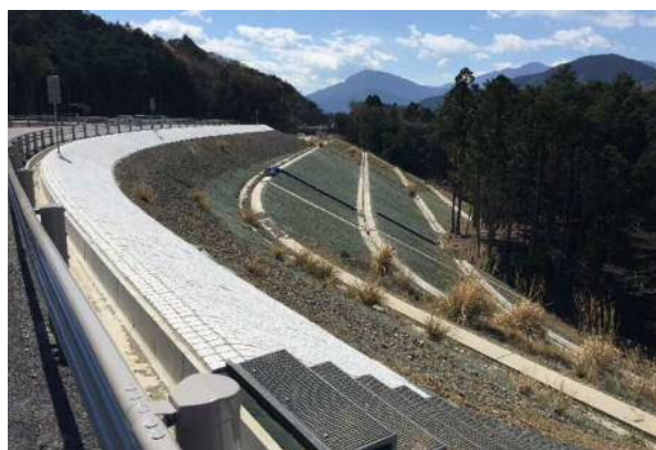
【仕上り面：目地・水抜パイプは不要】
