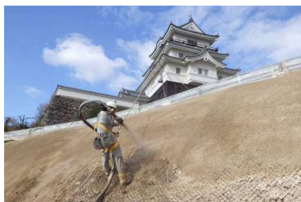
【乾式吹付作業】
