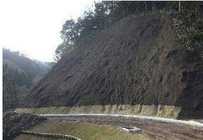
【施工箇所全景】
