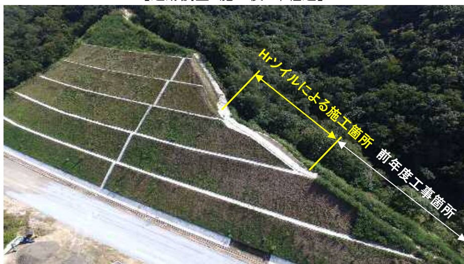
Hrソイル施工箇所(導入植物の侵入は無し)
