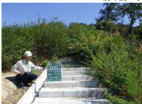
前年度工事箇所(階段付近は植生工)
