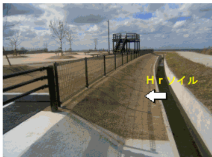
公園整備工事 盛土法面の防草工 【本設タイプ】
