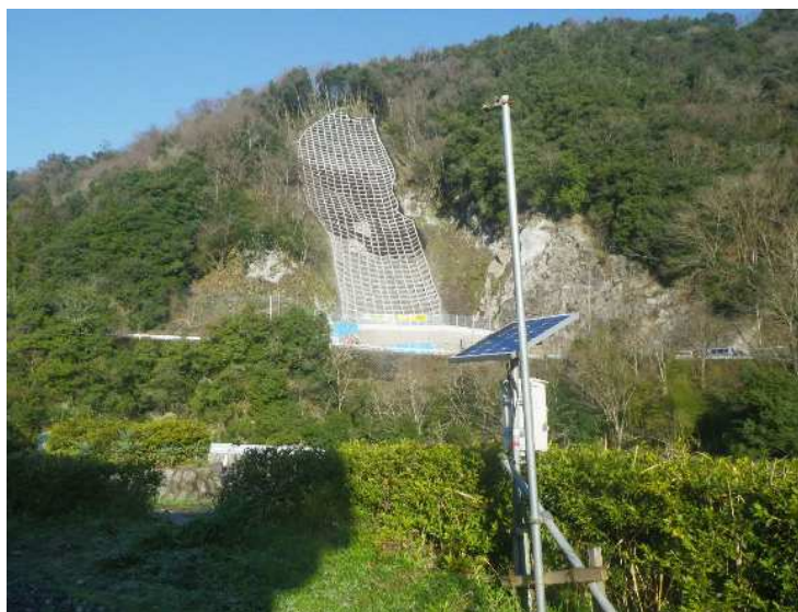
カメトル設置写真
