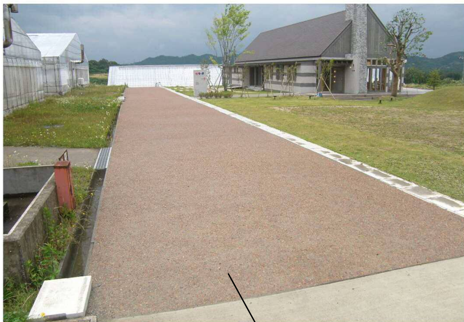
石州瓦コンクリート舗装
