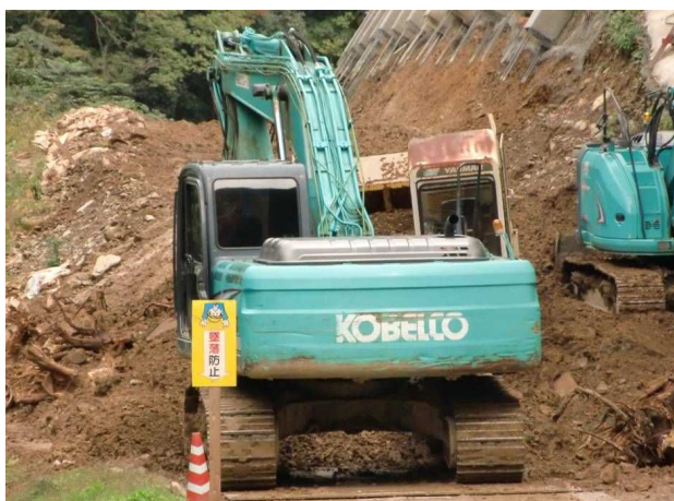
施工現場状況
