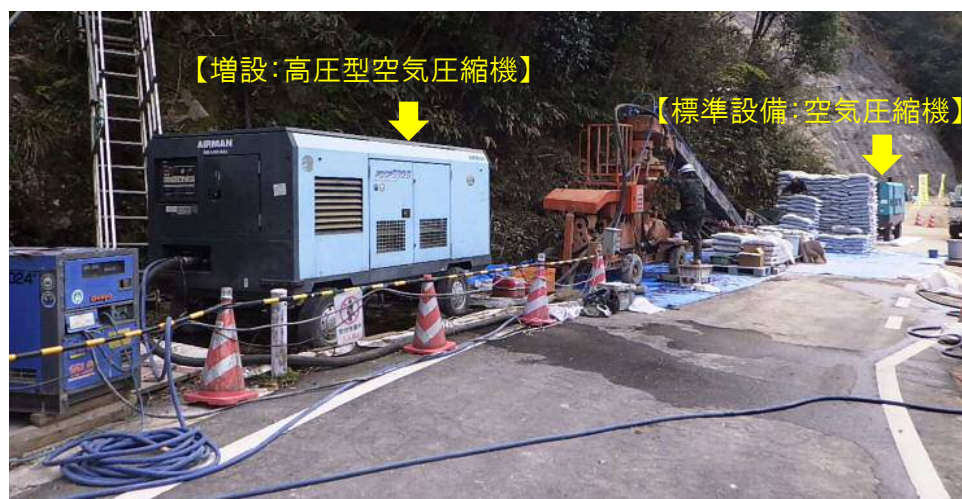
【吹付プラント】
