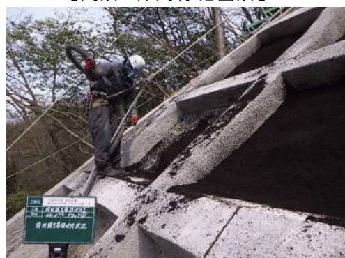
【+120m地点 吹付作業】
