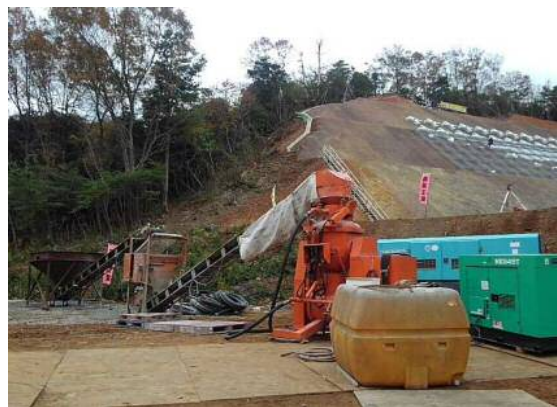
【吹付プラント】
