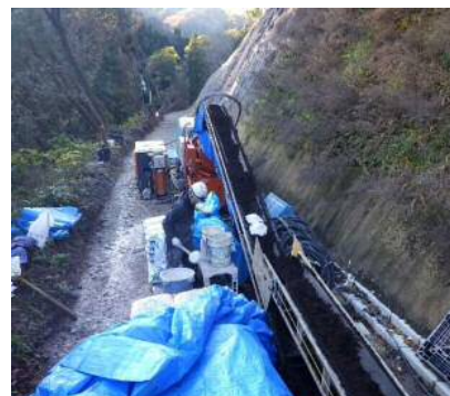
【吹付プラント作業】
