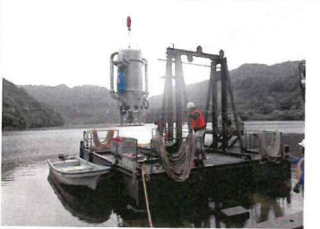
気液溶解装置沈設前セッティング終了状態
