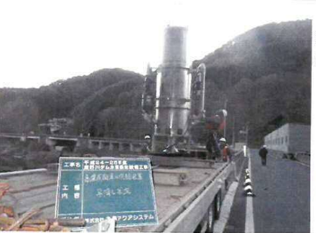
気液溶解装置沈設前セッティング終了状態
