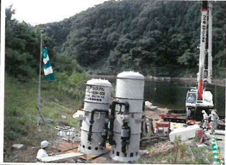
気液溶解装置沈設前セッティング終了状態
