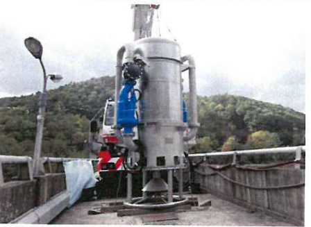
気液溶解装置設置の様子
