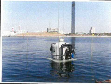
気液溶解装置沈設の様子
