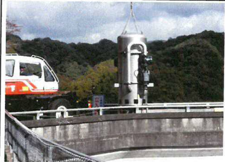
気液溶解装置沈設前セッティング終了状態
