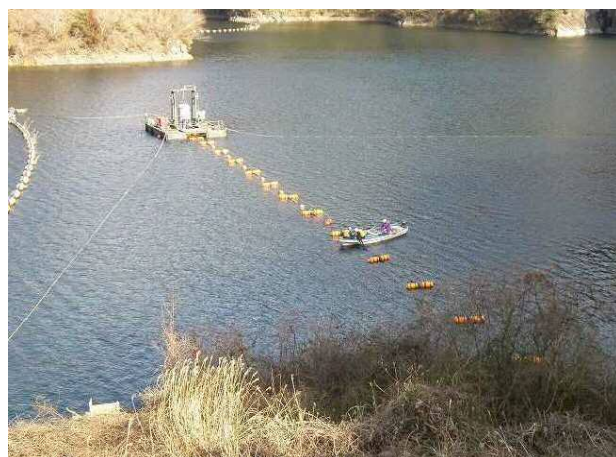
気液溶解装置設置作業
