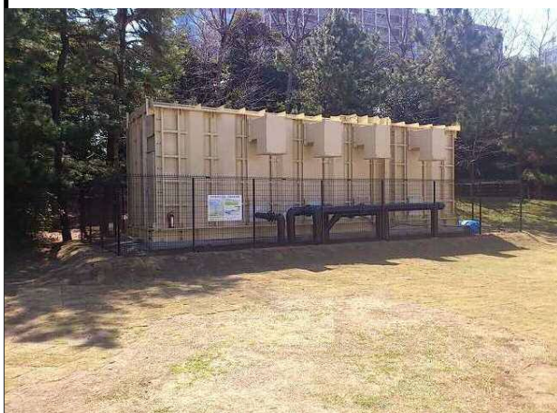
設備建屋外観
