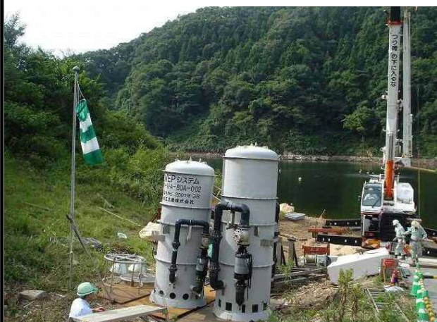
気液溶解装置組立完了
