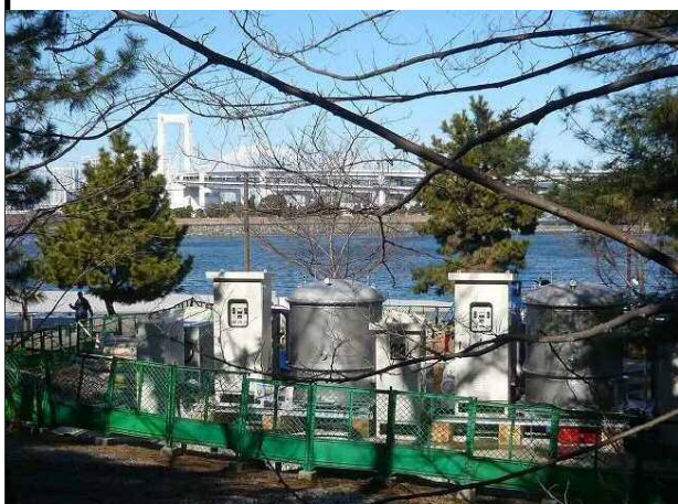
現場機材搬入後の様子 (画面奥:レインボーブリッジ)
