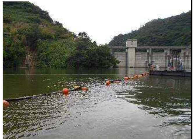
気液溶解装置設置作業
