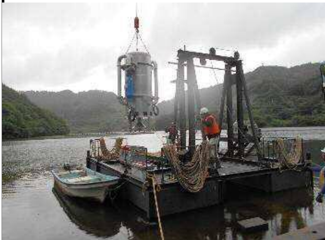
気液溶解装置吊込み
