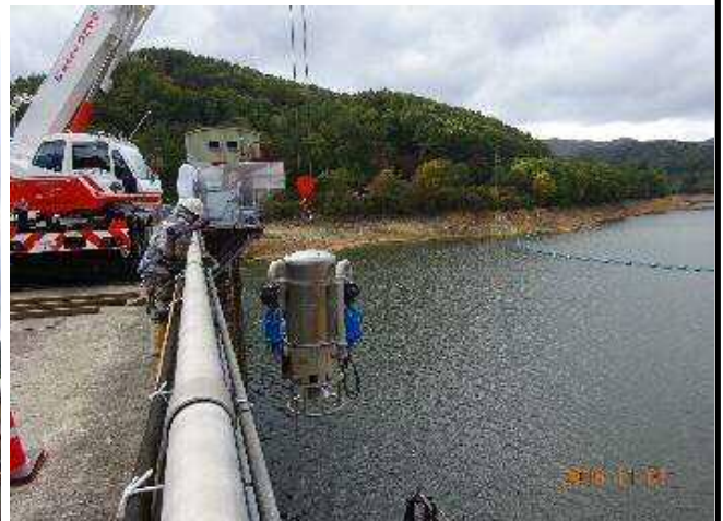
気液溶解装置吊降
