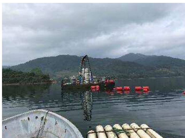
気液溶解装置設置作業
