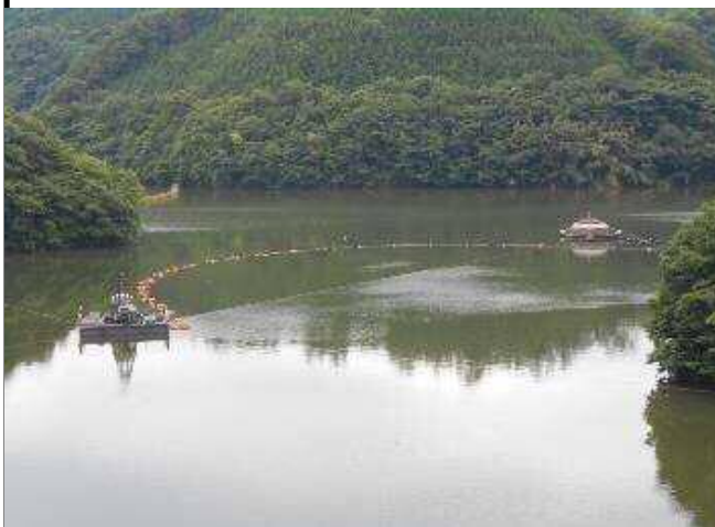
気液溶解装置設置作業
