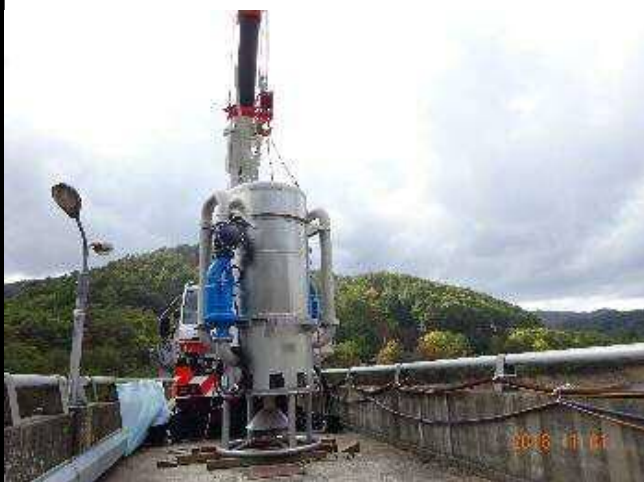
気液溶解装置組立完了
