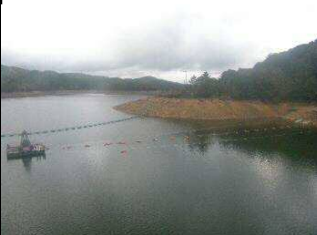
ケーブル・エアホース敷設
