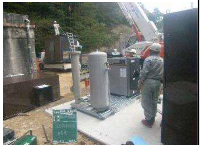
陸上設備設置
