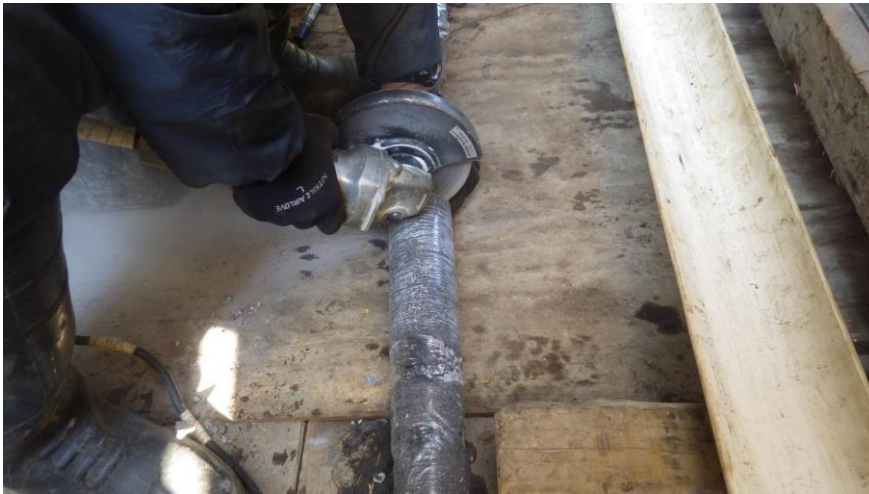
写真 10-2 ボーリングコアの切断状況
