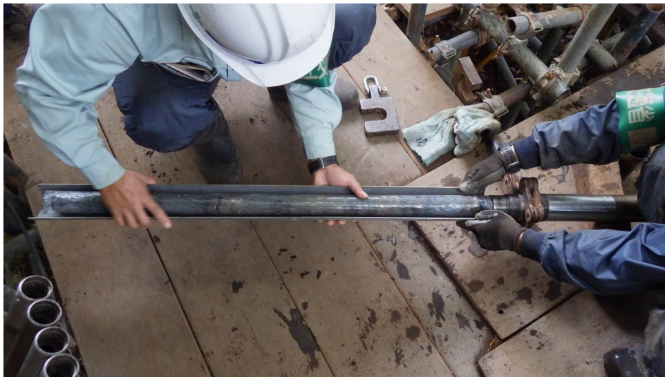
写真 10-1 コアチューブからの取り出し状況
