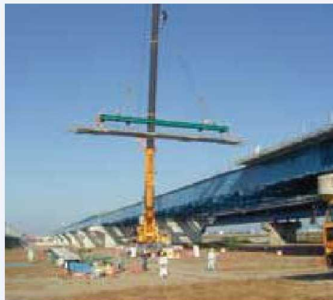
クレーンによる架設状況
