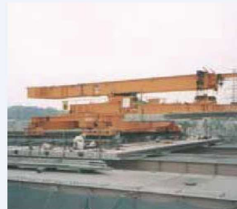
橋上架設機による架設状況
