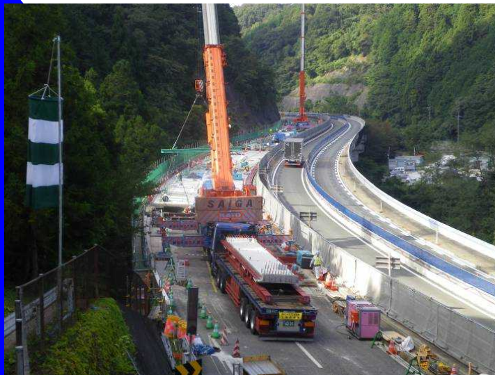
架設状況 全景
