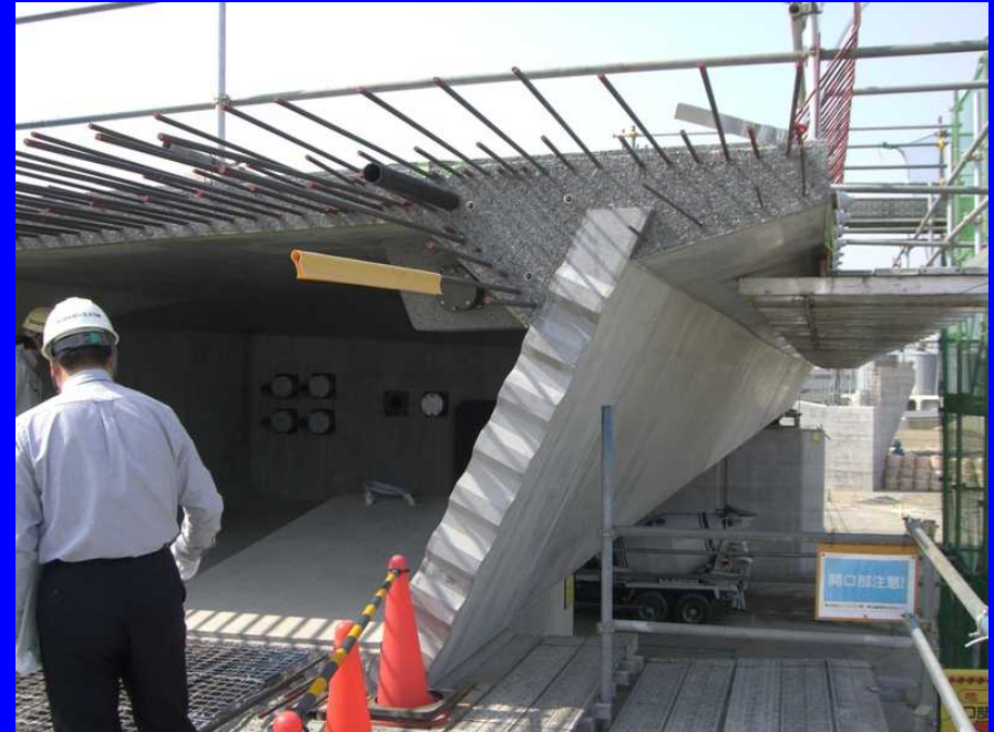
架設状況(支保工)
