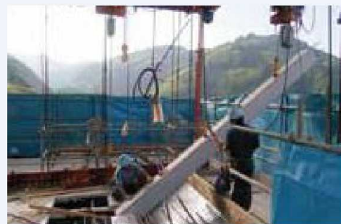
ストラット設置状況
