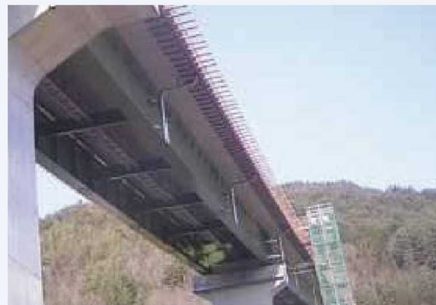
施工状況（下方より）
