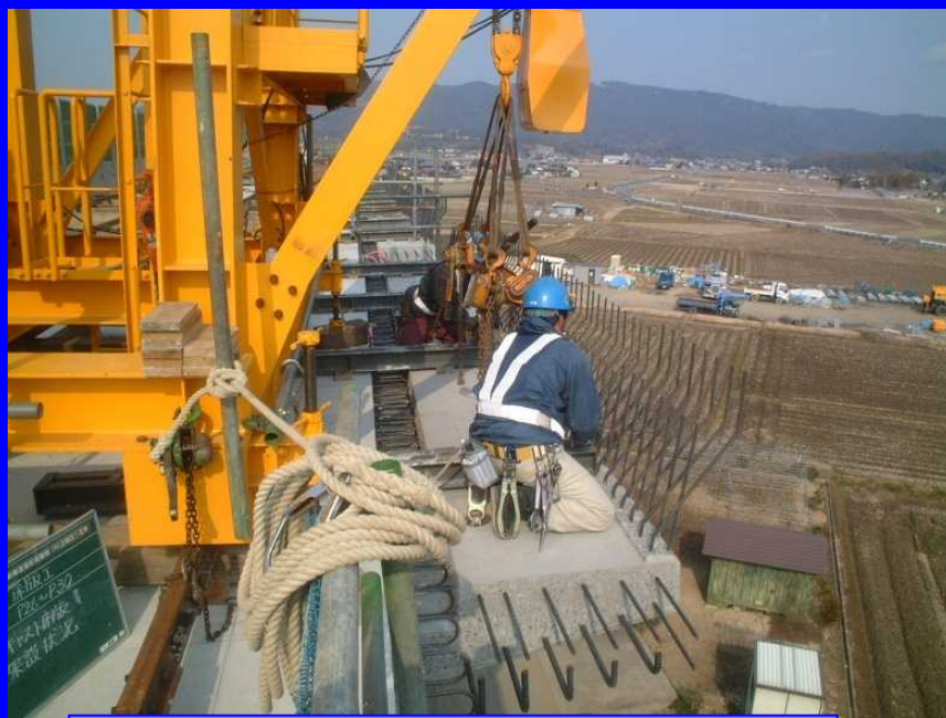
プレキャスト張出床版の架設
