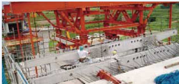
プレキャストリブ設置状況
