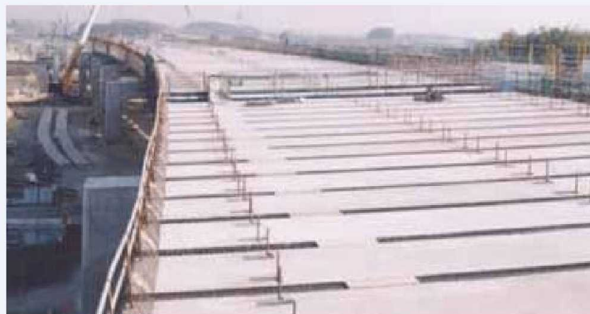
敷設完了状況
