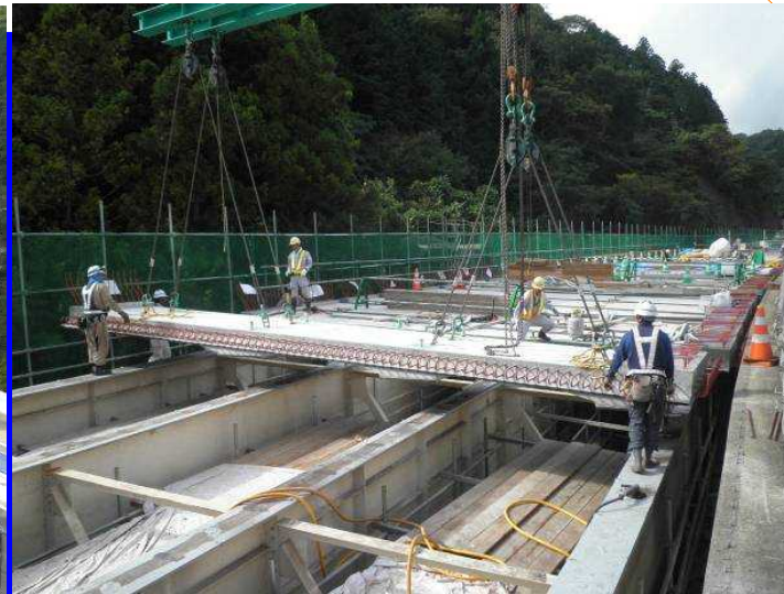
PcaPC床版架設
