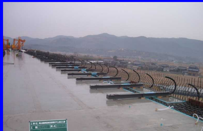
プレキャスト張出床版の設置状況
