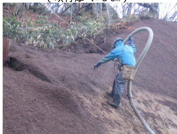
切土法面への吹付状況 (吹付厚 t=3 cm)
