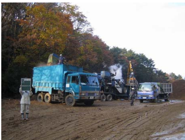
場内での伐根等の破碎状況 (大型チップパーにより破碎)
