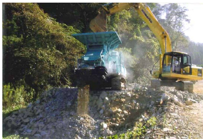
現場破碎状況
