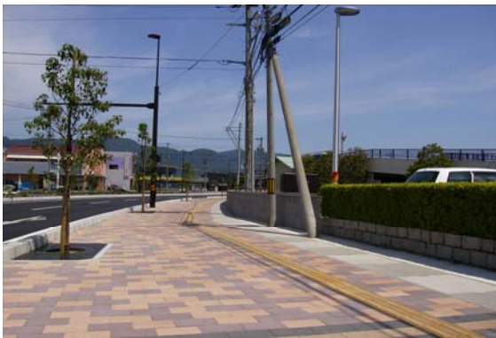
変更前（インターロッキングの使用事例）
