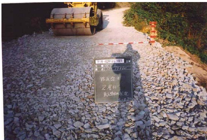
岩碎盛土施工状況
