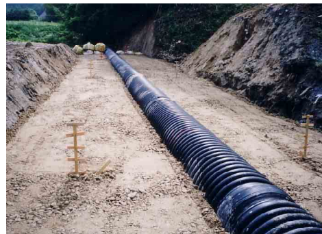
砕石基礎状況
