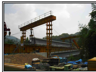
写真2 桁の架設状況
