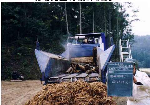
現場発生材破碎状況
