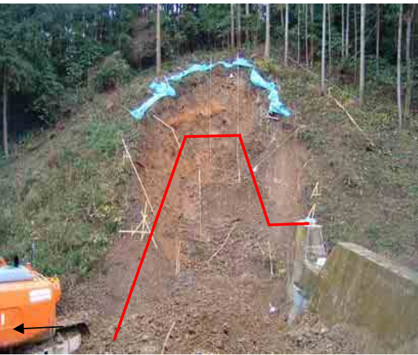
写真 既設堰堤の直下流を掘削
