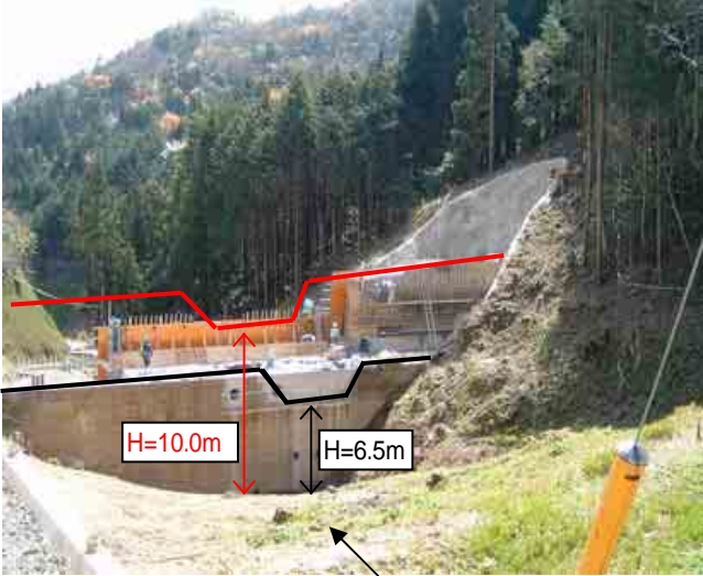
写真 嵩上げ部分の型枠組立
