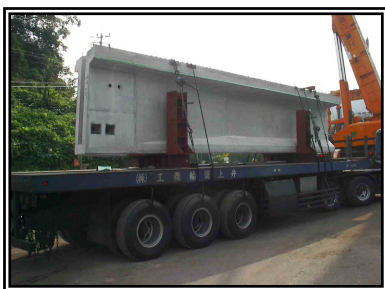
写真1 セグメントブロック搬入状況
