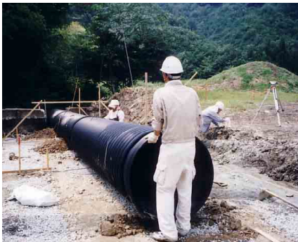
ポリエチレン管据え付け状況
