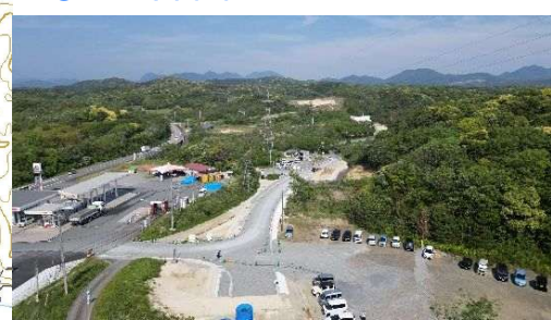
② 施工中箇所
