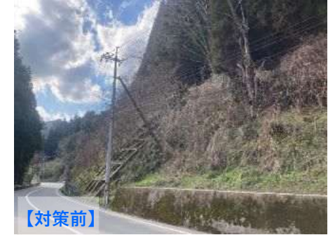
吹付砕工 (桜江金城線 桜江町長谷)
