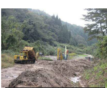
上流は工事を一時中断 していただいて観察
