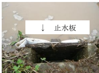
止水板の設置
