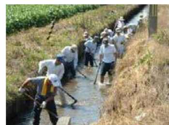
農業用水路の泥上げ
