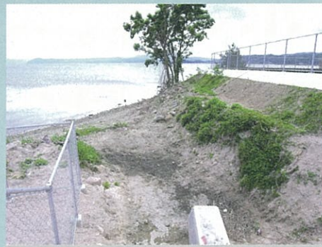
地下に浸透する万原駐車場側溝の排水
