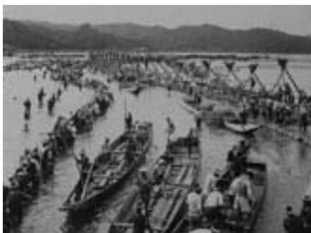
法華経堤防の決壊 (昭和9年、斐川町)
