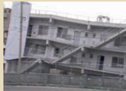
崩れかけたビル（広島市）
