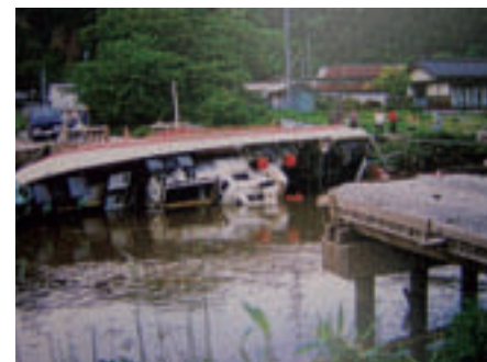
津波被害 (昭和58年、隠岐の島町)
