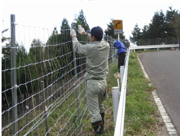
シカ防護策設置
