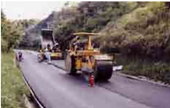
「エコアス」の施工の様子
