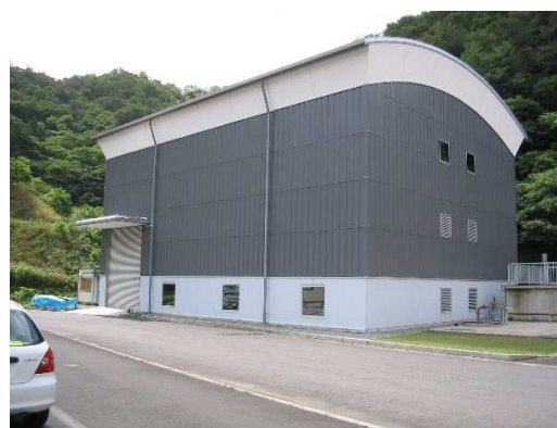
汚泥発酵分解処理プラント
