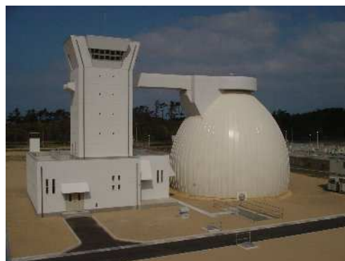
宍道湖西部浄化センターの汚泥消化タンク（平成 17 年度供用予定）
