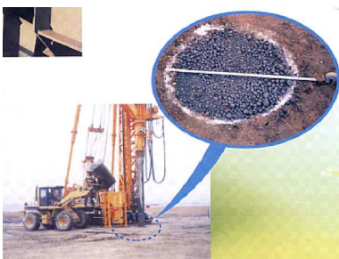
海砂代替材 (SCP 打設)
