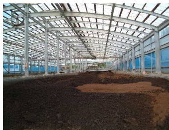
堆肥攪拌装置
