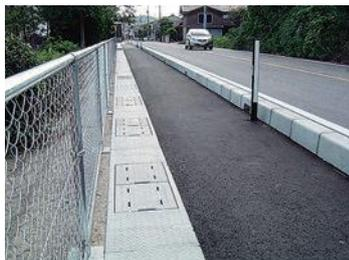
製品の施工例「CH-II可変側溝(無騒音)」
