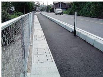
製品の施工例「CH-II可変側溝(無騒音)」
