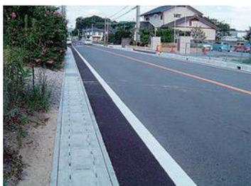
製品の施工例「道路側溝M(無騒音)」
