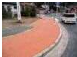
施工直後の色合い
