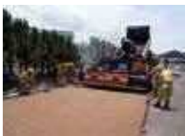
施工直後の色合い
