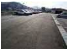
施工直後の色合い
