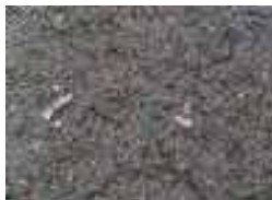
施工後3年を経過した色合い
